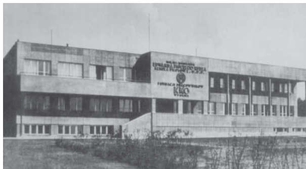
Budynek szkoły pilotów – widok od strony zachodniej
