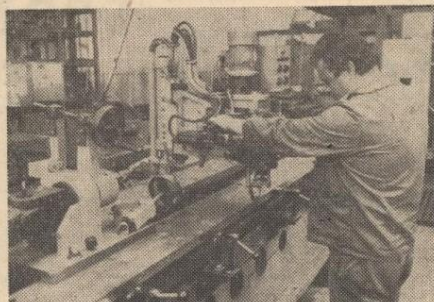
Urządzenie do wiercenia i prostowania profili lotniczych jest już gotowe. Mechanik E. Zieliński kontroluje sprawność funkcjonowania jego mechanizmów.
