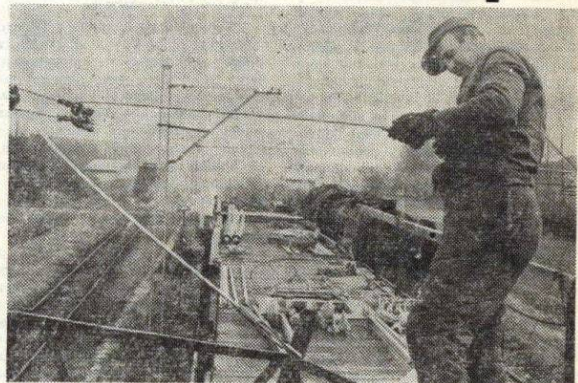
Dobiega końca zakładanie trakcji elektrycznej na odcinku linii kolejowej Lublin-Świdnik. Prace, które miały być zakończone do 1 listopada wciąż jeszcze trwają. Na zdjęciach pracownicy Przedsiębiorstwa Kolejowych Robót Elektryfikacyjnych w Warszawie pracują przy podwieszaniu kabla.
